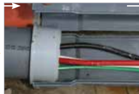
COLLER LA TROUSSE EPR EN PLACE
