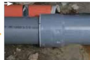
RÉSULTAT : UN CONDUIT ENTièrement REMIS EN ÉTAT
