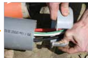
OUVRIR L'ADAPTEUR AUTOUR DES CÂBLES
