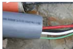
COUPER LE CONDUIT SELON LES DIRECTIVES ACCOMPAGNANT LA TROUSSE EPR
