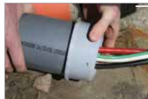
COLLER L'ADAPTEUR SUR LE CONDUIT
