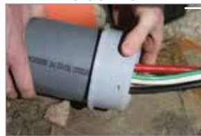
COLLER L'ADAPTEUR AU CONDUIT
