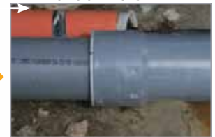
RÉSULTAT: CONDUIT TOTALEMENT RESTAURÉ
