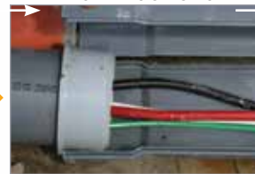
COLLER LA TROUSSE EPR À SA PLACE
