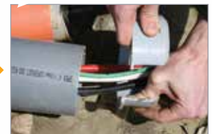
OUVRIR ADAPTEUR AUTOUR DU CÂBLE
