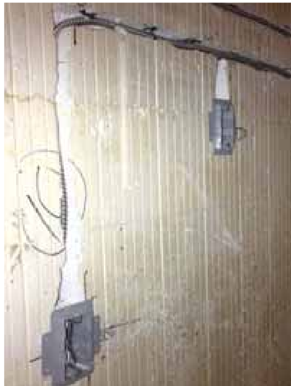
Plus de 700 boîtes électriques ont été installées dans ce nouvel hôtel pour les connexions électriques et de données.
